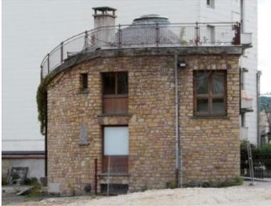
Appareillage en pierres de Villacourt et garde-corps en inox sur toiture-terrasse.
