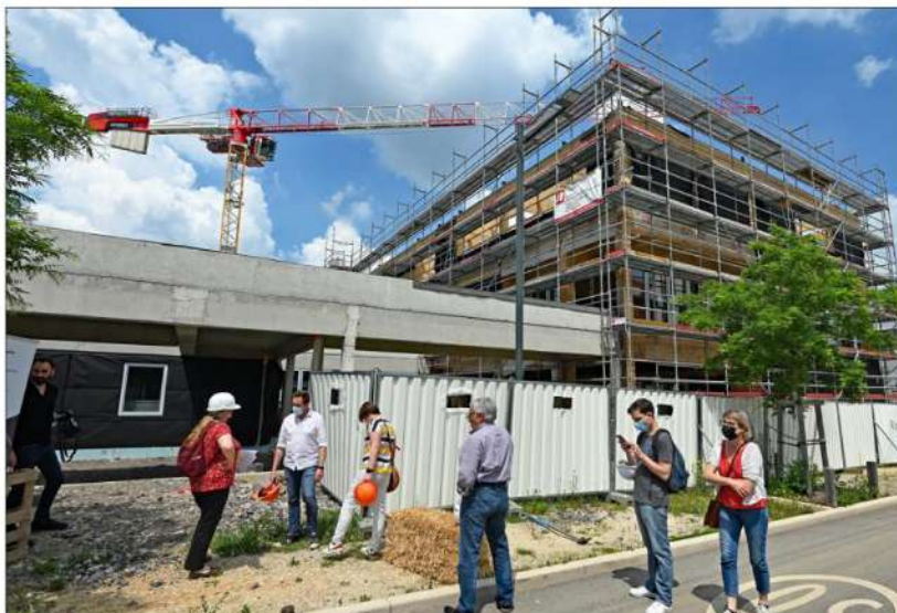
Une visite du chantier du futur collège était organisée ce vendredi pour les professionnels de la construction. Photo ER/Cédric JACQUOT
