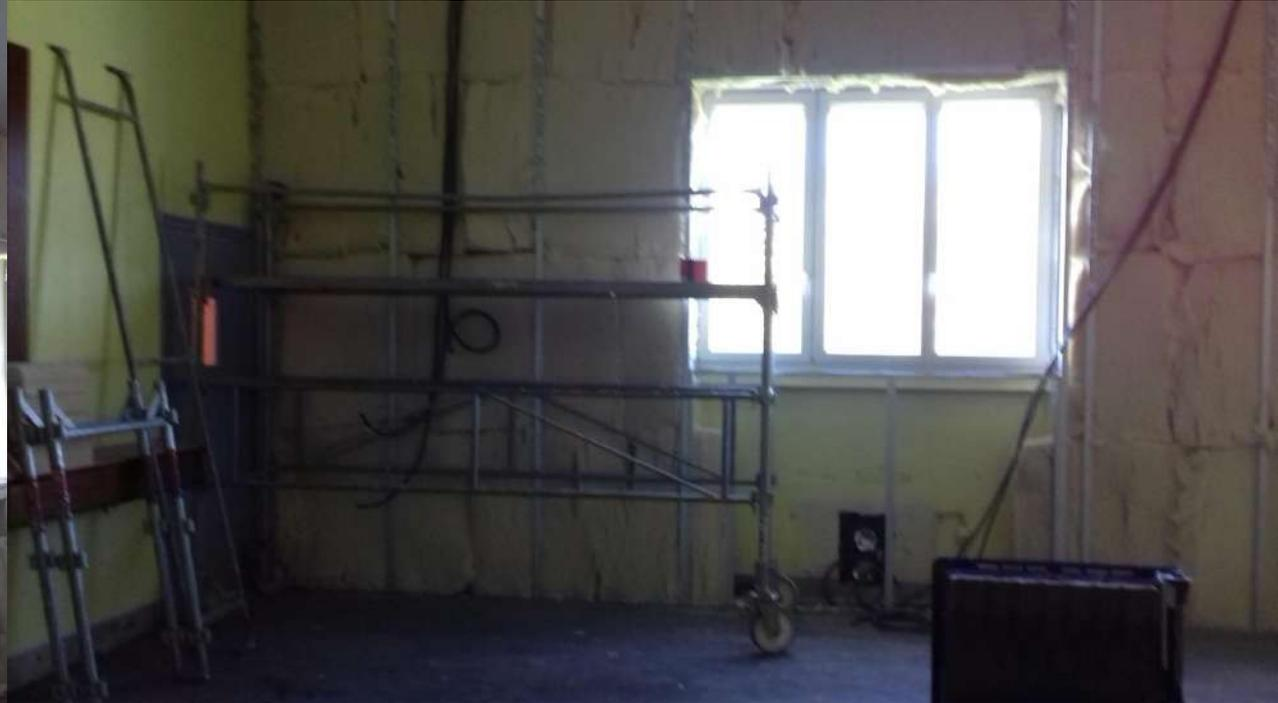
**Les isolants en laine sont mis en œuvre à la salle des fêtes de Mandres-aux-Quatre-Tours (54)**
