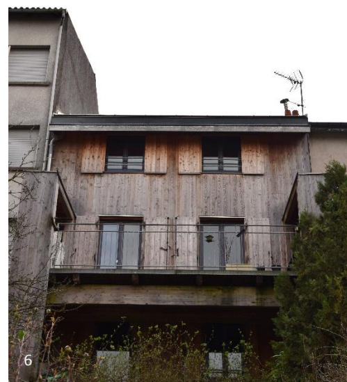
La terrasse autoporteuse vue depuis le jardin
